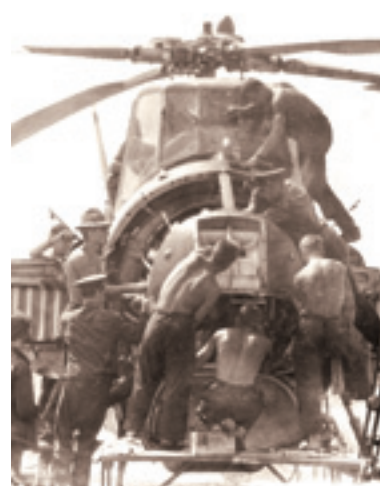
Выполнение регламентных работ на вертолете Ми-4. Пришибская авиаэскадрилья
