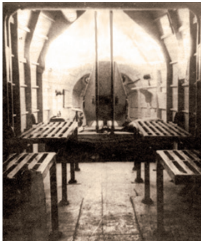
Грузовая кабина планера Г-11. Впереди – кресло пилота. По бортам – скамейки для десантников. При перевозке грузов их можно было сложить вниз или просто снять. Скамейки имеют разрыв в районе грузовой двери
