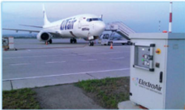
Аэродромные источники электропитания переменного напряжения 200В 400Гц и постоянного тока 27В
