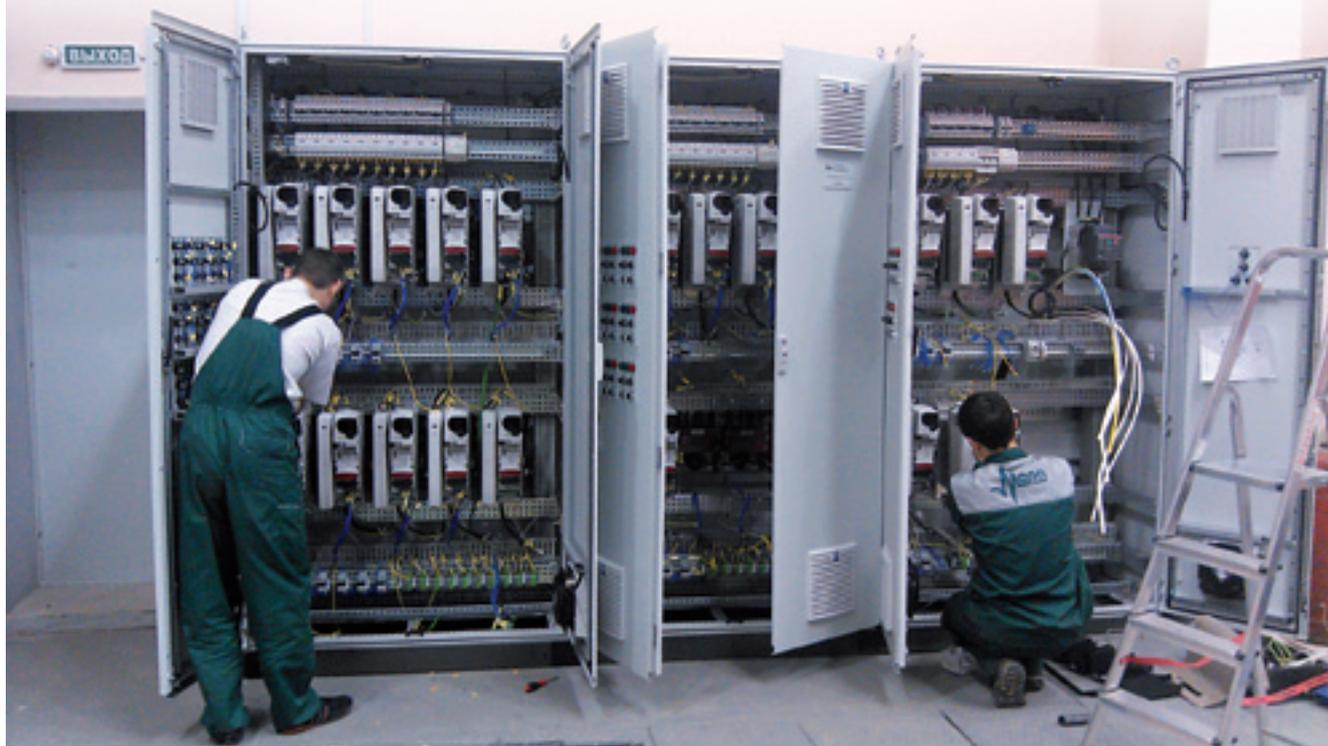
*Сборка контроллерных шкафов на стенде статических испытаний*
