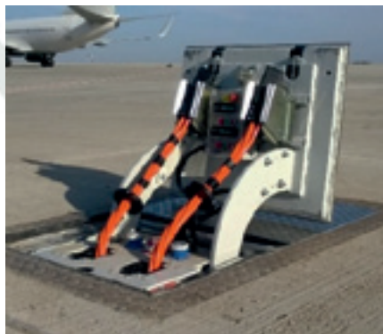
ПИТ-системы 400Гц, 50Гц, сжатый воздух, вода
