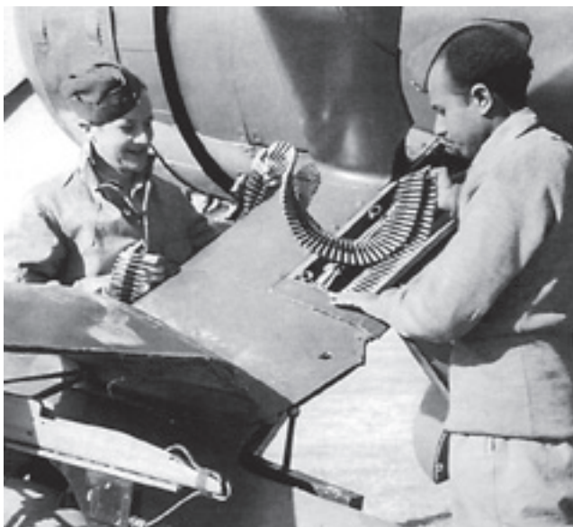
Зарядка курсового пулемёта, размещённого под обтекателем стойки шасси
