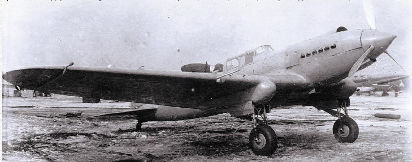
Первый опытный бронированный двухместный (лётчик и стрелок) штурмовик ЦКБ-55 (БШ-2) с высотным двигателем АМ-35А впервые был поднят в воздух 02.10.1939 г. лётчиком-испытателем Героем Советского Союза В.К. Коккинаки
