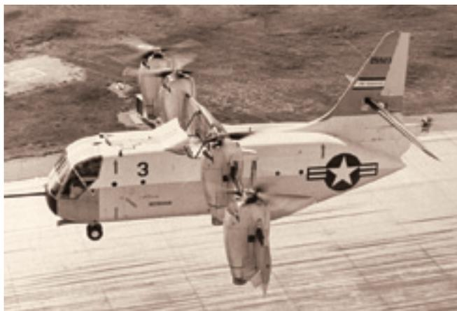
**Конвертоплан ХС-142 выполняет вертикальный взлёт**
