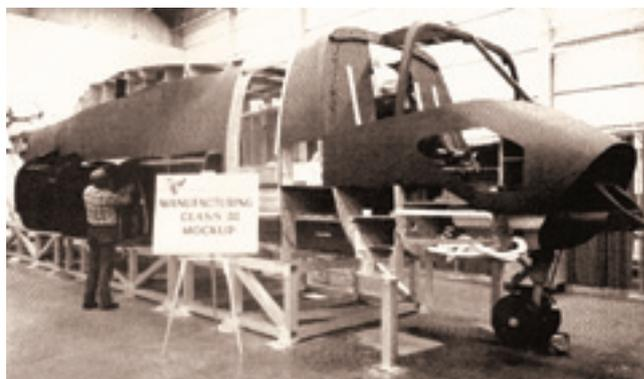
**Деревянный макет «Оспри». В дальнейшем фирмы перешли на трёхмерное компьютерное моделирование проектов. Это позволило отказаться от постройки макетов. Обратите внимание на большой иллюминатор под фонарём кабины и наклонный первый шпангоут. Его задача – недопустить зарывание конвертоплана при вынужденной посадке на брюхо. Там же видно место для установки заправочной штанги**
