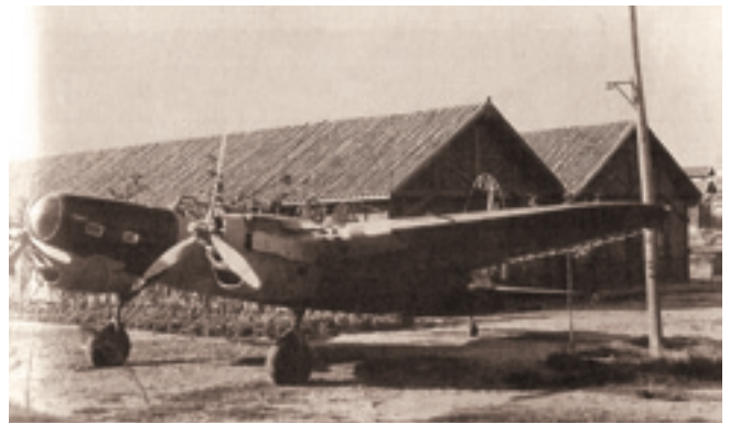
Китайский аналог СБ деревянной конструкции. Проходил летные испытания в 1944 г.
