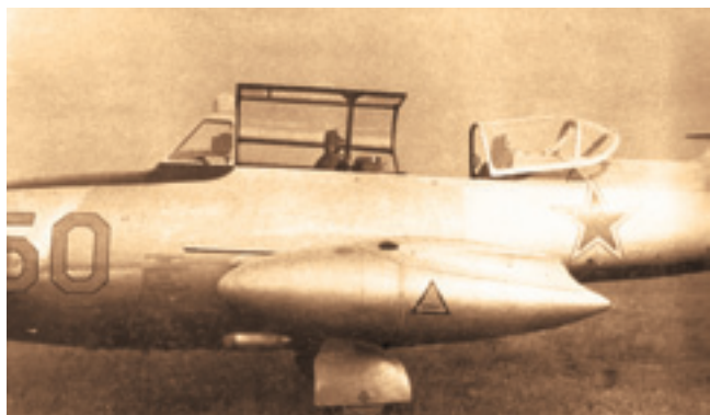
Два снимка Як-23УТИ/П борт 50 после новых доработок с удлинённой крышкой передней кабины и крышкой старого типа на задней кабине
