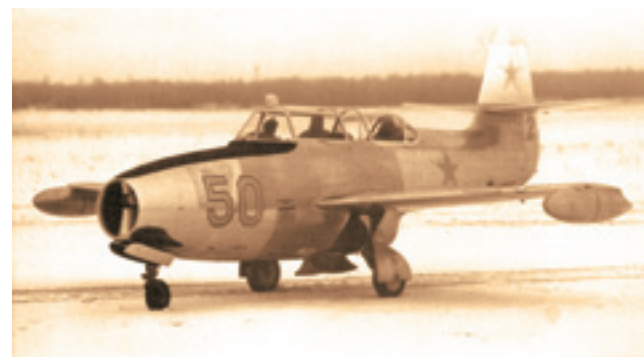
Второй опытный Як-23УТИ борт 50 с начальным козырьком кабины
