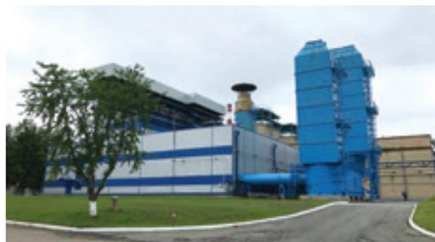
**Производственный корпус для испытаний камер сгорания ГТД на Лыткаринском машиностроительном заводе**
