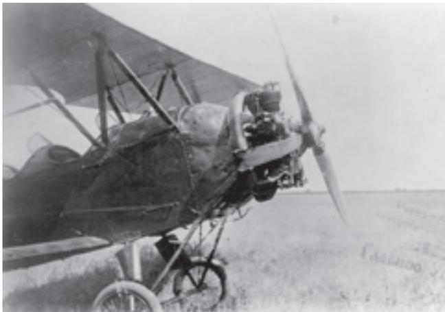
**У-2 с винтом-глушителем. Видны патрубки от коллектора к втулке винта**
