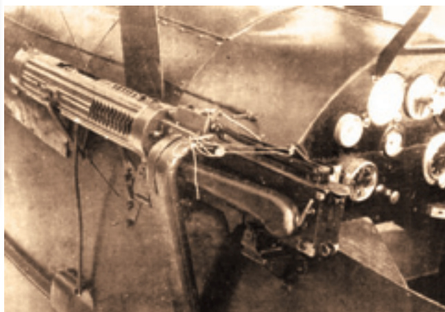
Пулемет ПВ-1 устанавливался слева от кабины так, чтобы при необходимости летчик мог устранить задержку путем ручной перезарядки
