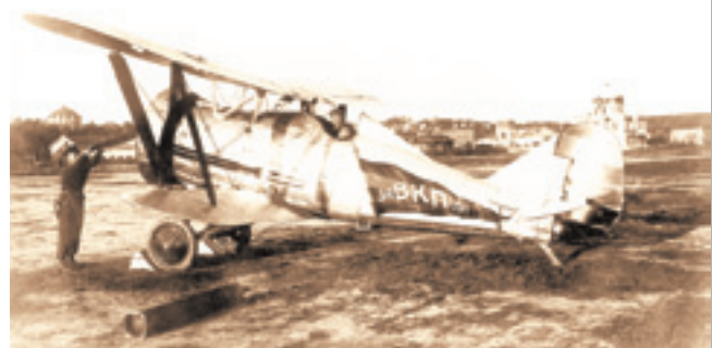
Самолет-истребитель И-5 на Центральном аэродроме (над головой механика, держащего лопасть винта, виден купол Петровского дворца). Пулеметы ПВ-1 располагались побортно в районе кабины пилота (закрыты обтекателями), для прохода траассы пуль в бортах фюзеляжа сделаны соответствующие желоба
