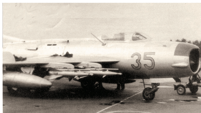
МиГ-19ПМ борт.№35 с ракетами РС-2У и дополнительными топливными баками. В 1958-1960 годах было построено 369 МиГ-19ПМ (вместе с опытными)
