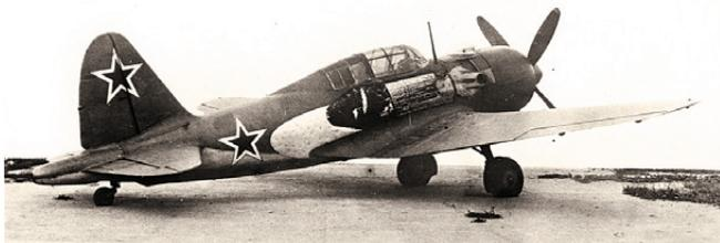
Су-7 перехватчик с ЖРД-ускорителем, 1944 г.
